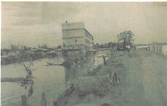
運動場真中の防潮堤
